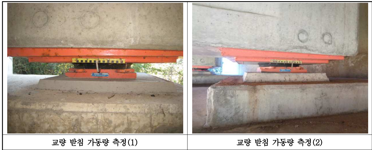
【사진 3.3.15】 교량받침 이동량 측정
