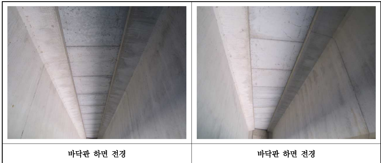
【사진 3.3.2】 바닥판하면 전경
