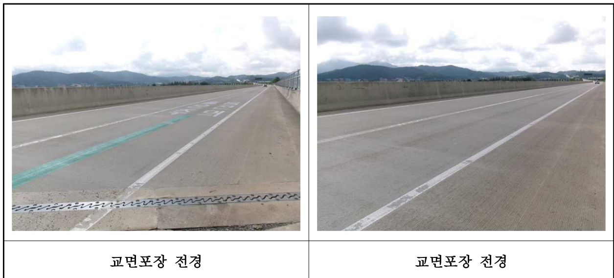
【사진 3.3.44】 교면포장 전경
