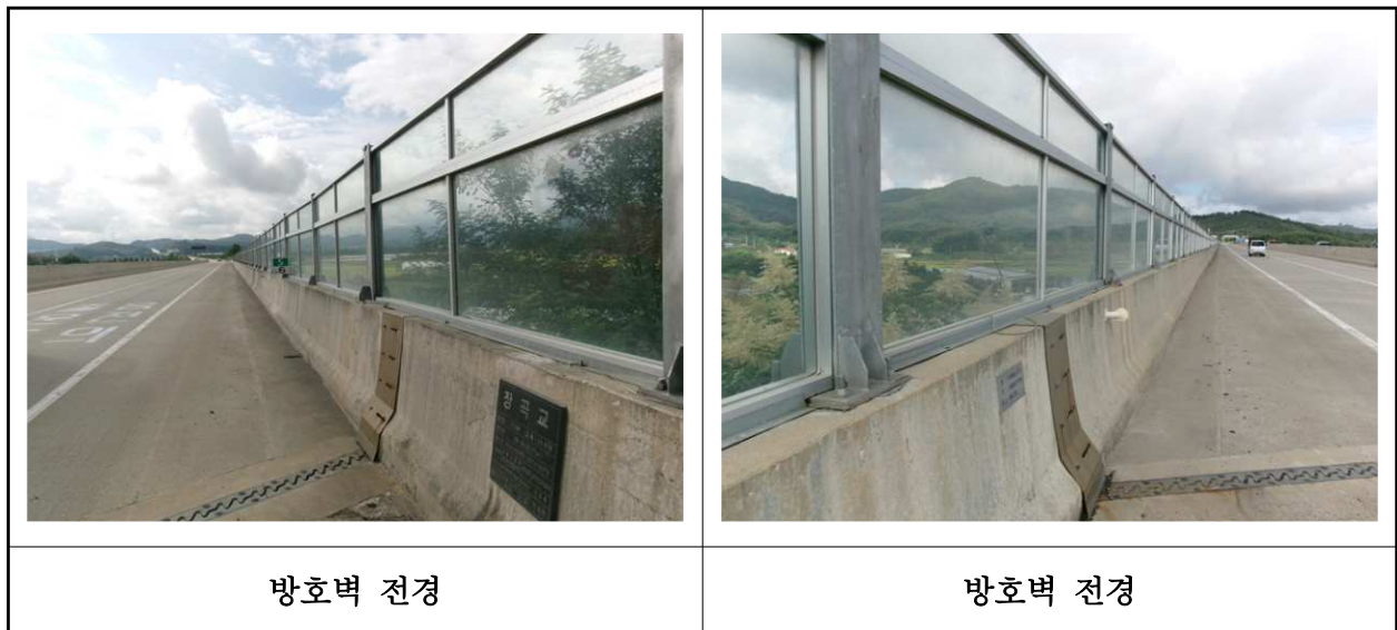
【사진 3.3.48】 방호벽 및 중앙분리대 전경
