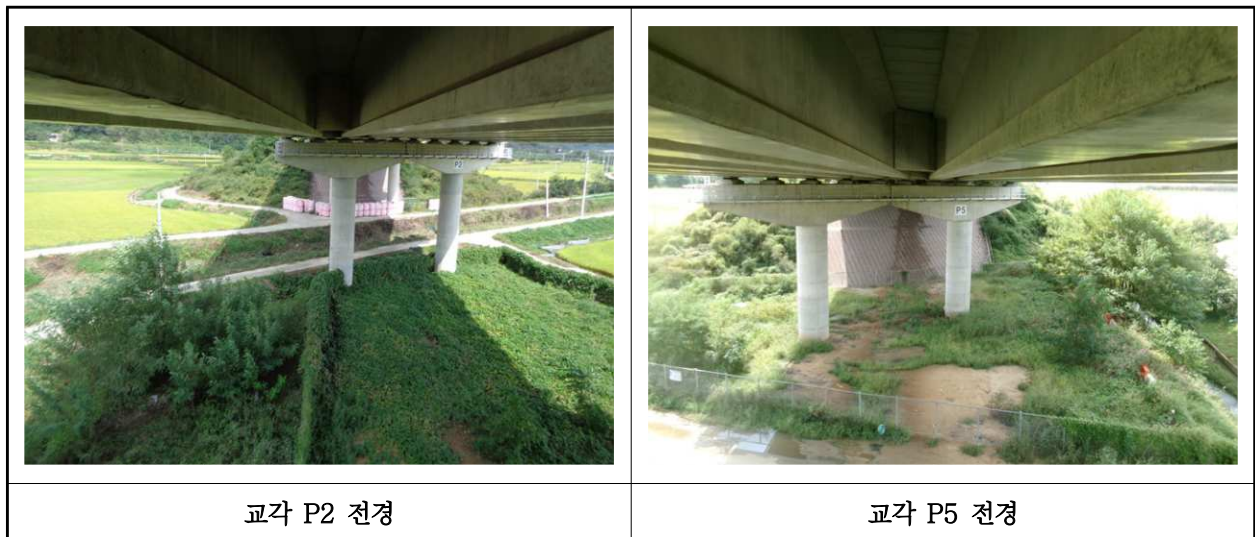
【사진 3.3.35】 교각 전경
