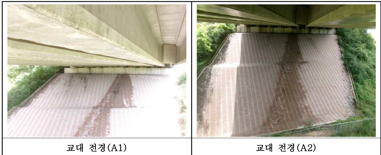
【사진 3.3.33】 교대 전경
