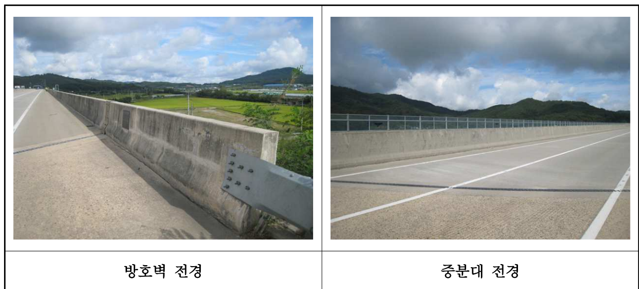
【사진 3.3.23】 방호벽 및 중앙분리대 전경
