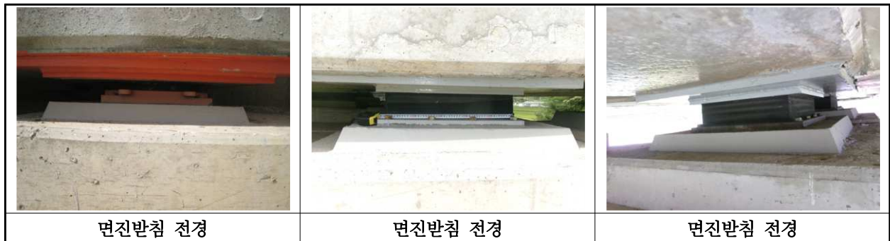
【사진 3.3.12】 교량받침 전경
