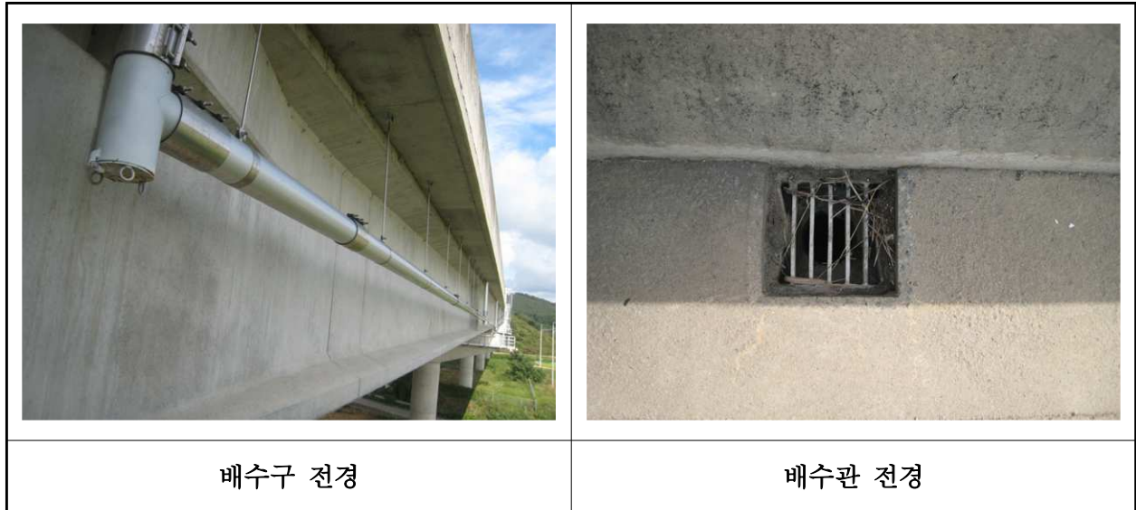
【사진 3.3.21】 배수시설 전경
