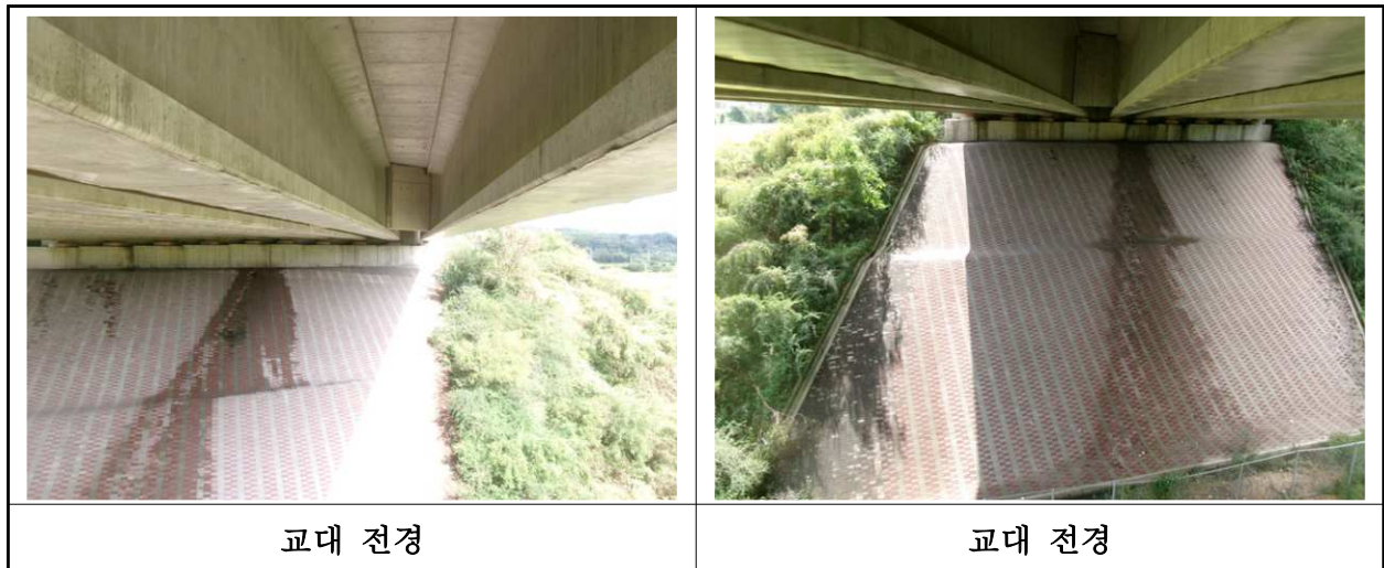
【사진 3.3.8】 교대 전경
