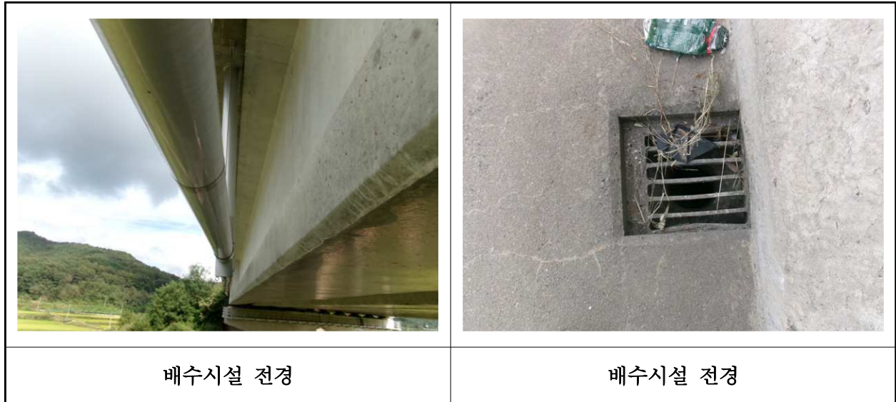
【사진 3.3.46】 배수시설 전경
