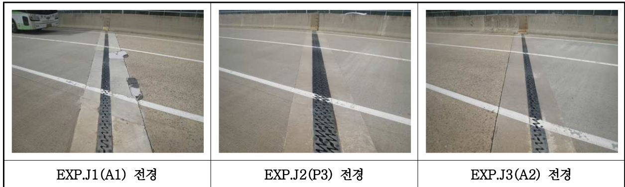
【사진 3.3.16】 신축이음장치 전경
