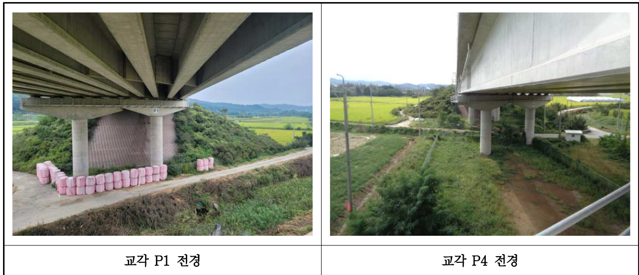
【사진 3.3.10】 교각 전경
