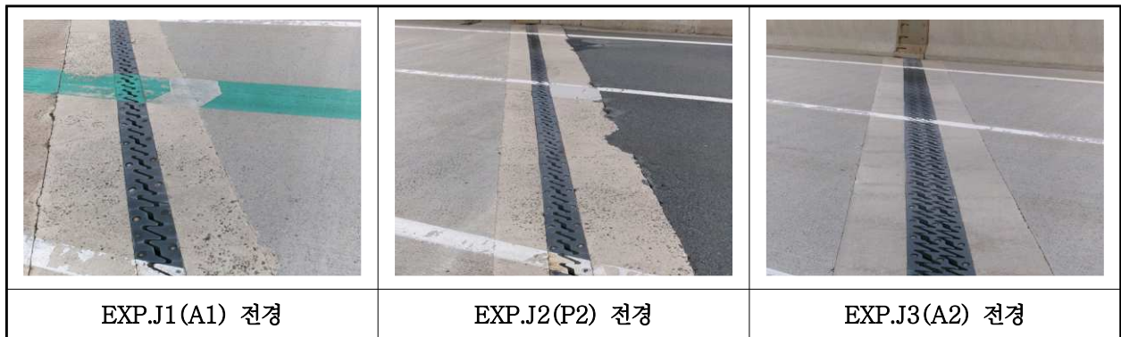
【사진 3.3.41】 신축이음장치 전경
