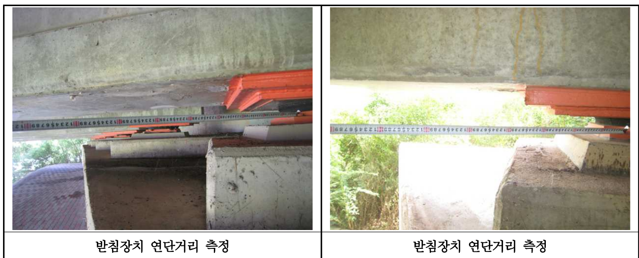
【사진 3.3.14】 교량받침장치 연단거리측정
