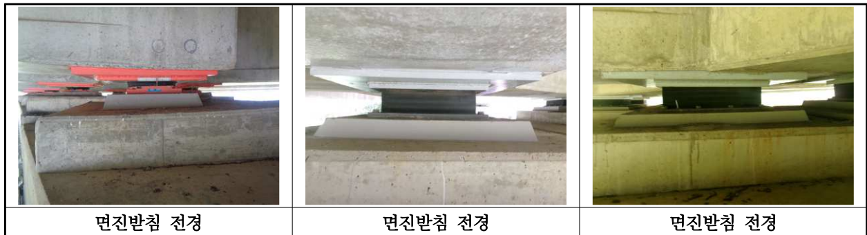
【사진 3.3.37】 교량받침 전경
